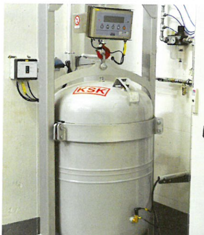
Bild 3: Leckageüberwachung mittels Gewichtskontrolle.
